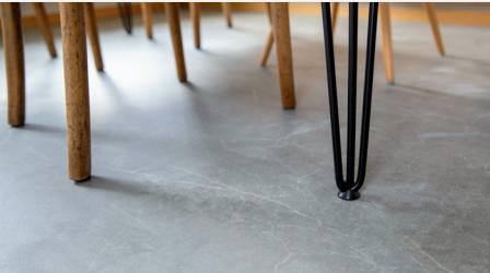
Revêtement de sol multicouche (cushion vinyle) faiblement aggloméré dans la sous-couche
