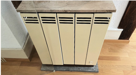
Radiateur électrique à accumulation
